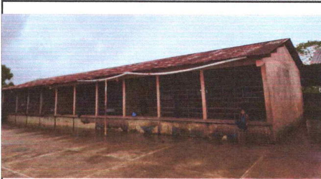
Foto 3: CAMBIO DE TECHOS Y PINTURA
