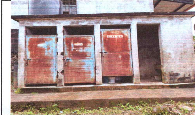
Foto 1: MATENIMIENTO DE BAÑOS, PUERTAS Y PARED
