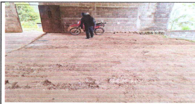
Foto 5: CAMBIO DE PISOS AREA 160 M2
