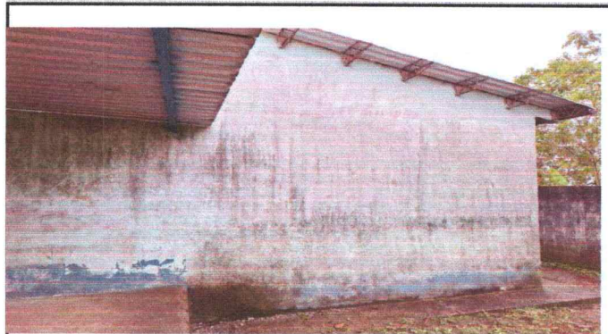
Foto 4: PINTURA DE PARED INTERIOR Y EXTERIOR
